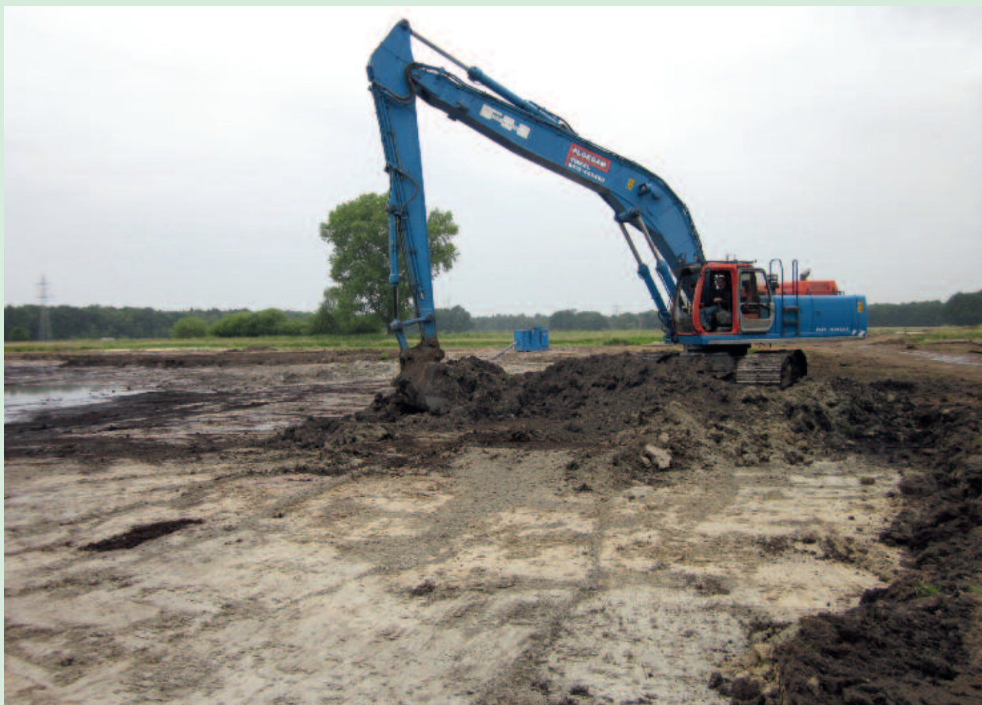
Foto 3. Ontgrondingswerkzaamheden in de Grashut (Weeterbos) (foto: Sjors de Kort).
