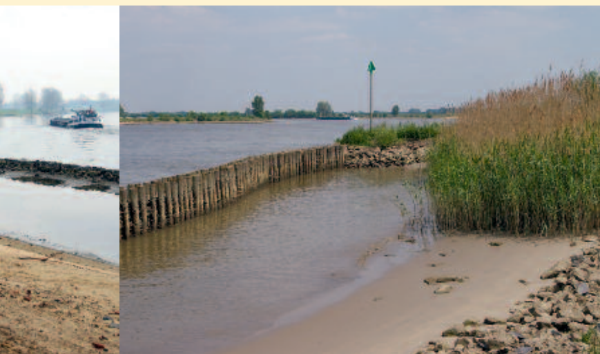
Foto 3. Natuurvriendelijke oever langs een benedenloop met getijdeninvloed. Achter een golfbrekende vooroever van palen met rijshout is Riet aangeplant (foto: Bert Overkamp, 2011).
